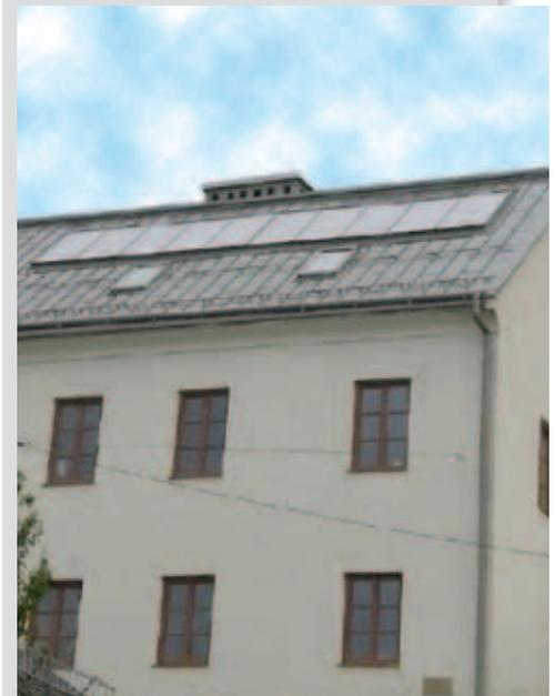
Gemeindefacharzt Dr. Anton Kammerer zur Installation einer 20 m<sup>2</sup> großen thermischen Solaranlage mit 2.000 l Pufferspeicher zur Warmwasseraufbereitung und Heizungsunterstützung. Die Anlage wurde im Zuge einer neuen Dachdeckung errichtet.
